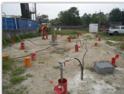
Figura 8-3: Allestimento del campo per una bonifica per via biologica
