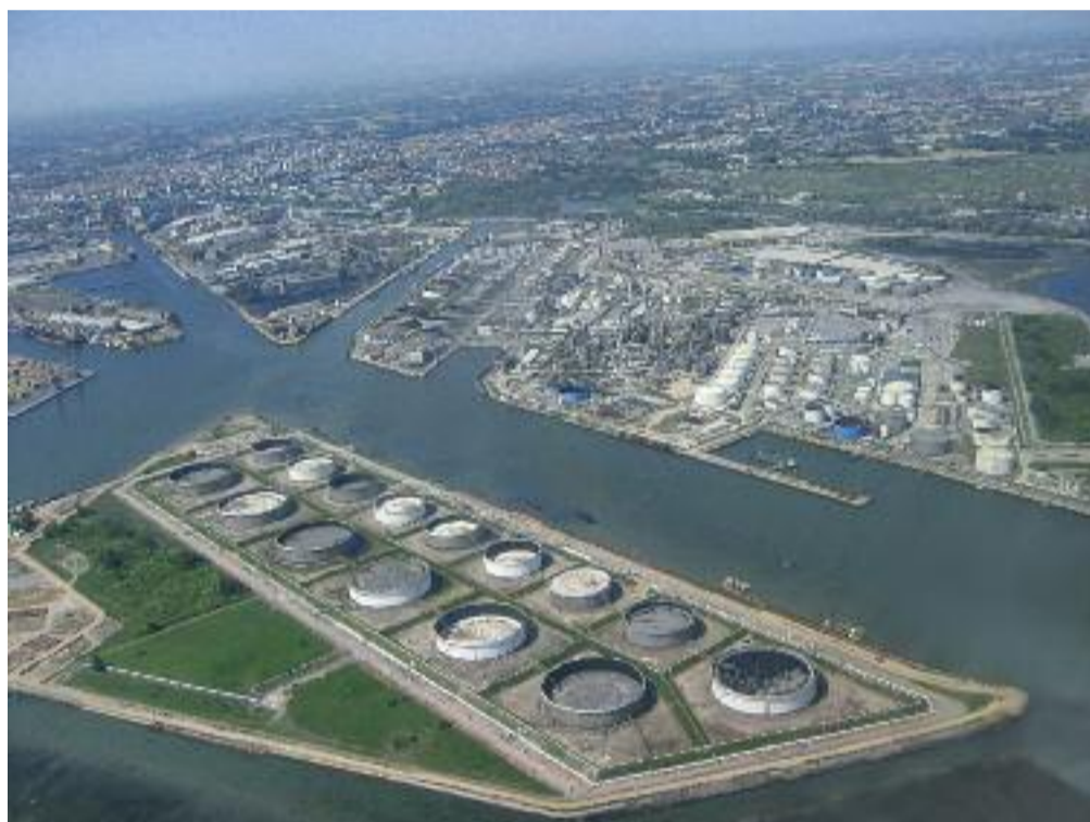
Veduta aerea della raffineria di Venezia. Grazie al progetto Green Refining di Eni gli impianti tradizionali saranno convertiti, entro il 2013, in "bio-raffineria" per la produzione di bio-carburanti.
