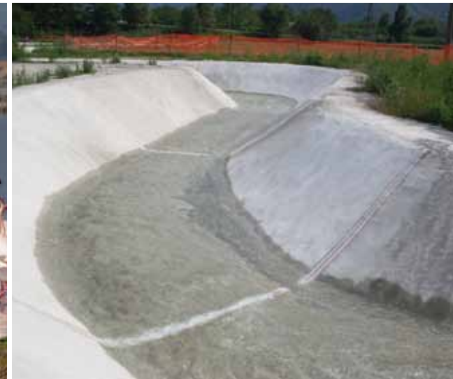
| impermeabilizzazione torrente
