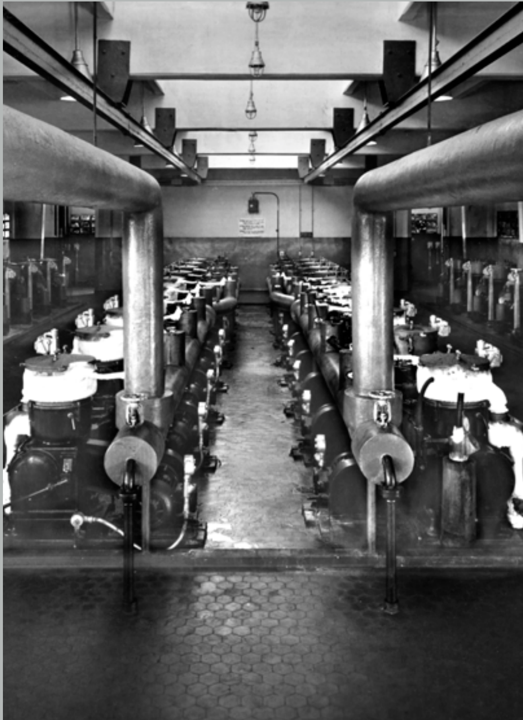
1941. Impianti lubrificanti e paraffina - dettaglio
