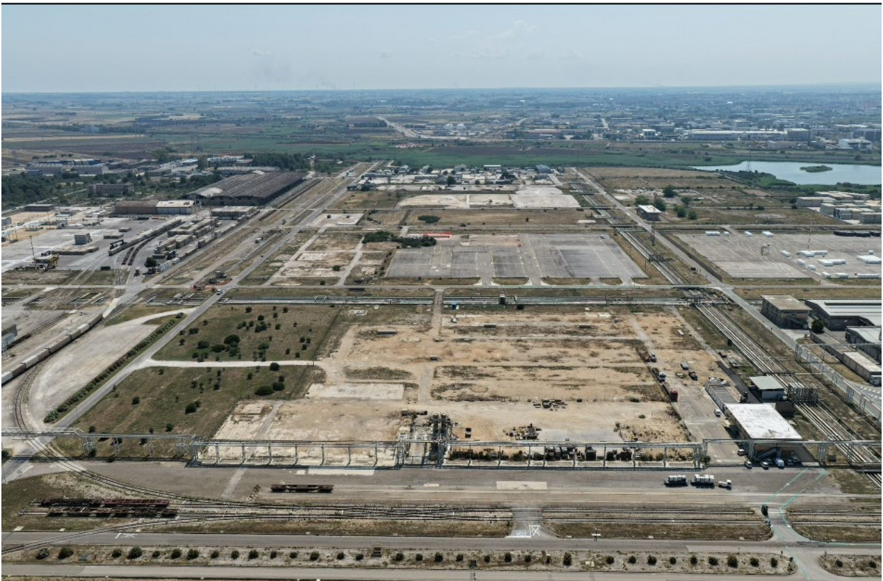
Area dove verrà costruiti lo stabilimento Eni Storage Systems Brindisi
