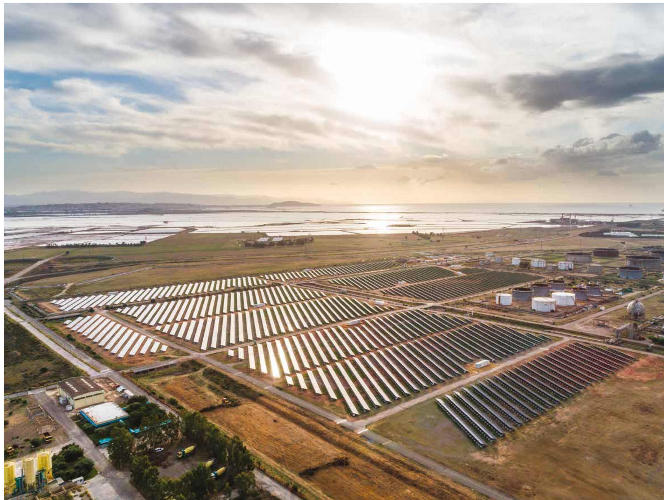
Campo fotovoltaico Eni. Assemini, Cagliari.
