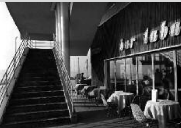
▲ STAZIONE DI SERVIZIO AGIP DI OMEGNA, VERBANIA
