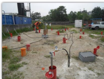
Figura 8-3: Allestimento del campo per una bonifica per via biologica
