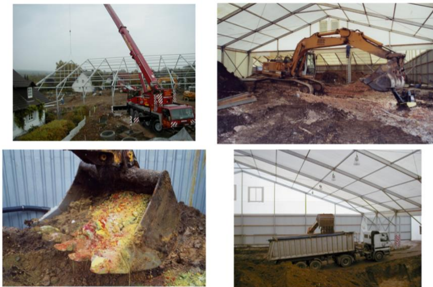
Figura 6-24 Caso applicativo di scavo e smaltimento (Fonte: Professor Petrangeli Papini)
