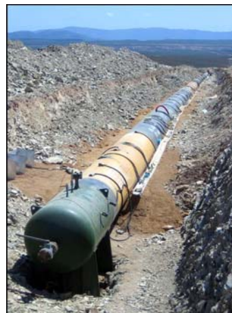
Le due linee del tratto pilota in acciaio X100
