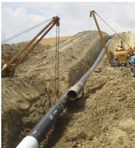
Costruzione del tratto dimostrativo in acciaio X80 in Sicilia
