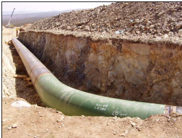
Le due linee del tratto pilota in acciaio X100
